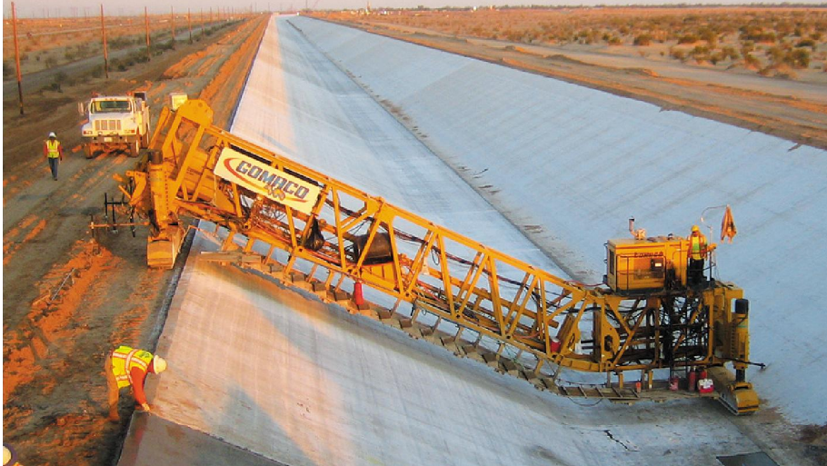
Цилиндрические финишеры отделки покрытия
